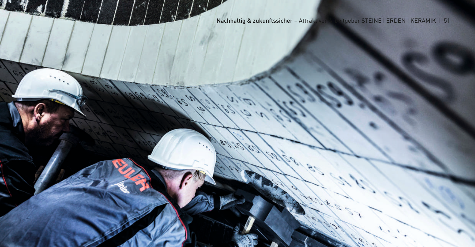
Präzise Arbeit: Fachpersonal für Montage und Supervision, Foto: Steuler Holding GmbH
